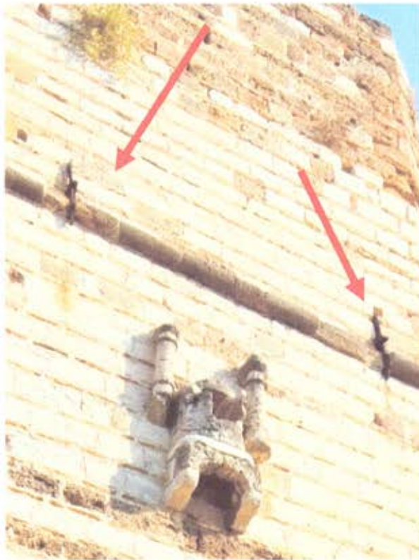
Η ύπαρξη σιδηρών ελκυστήρων
