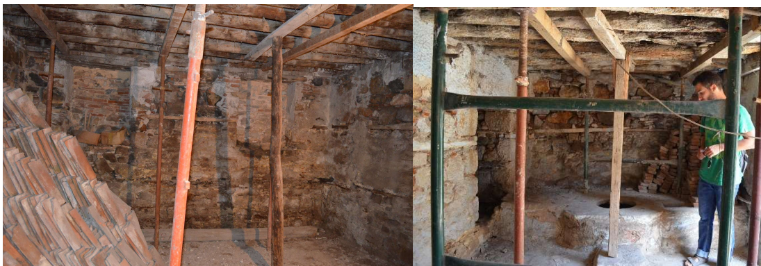
Ανατολικό τμήμα διαδρόμου ισογείου και ανατολικός τοίχος ανατολικού δωματίου
