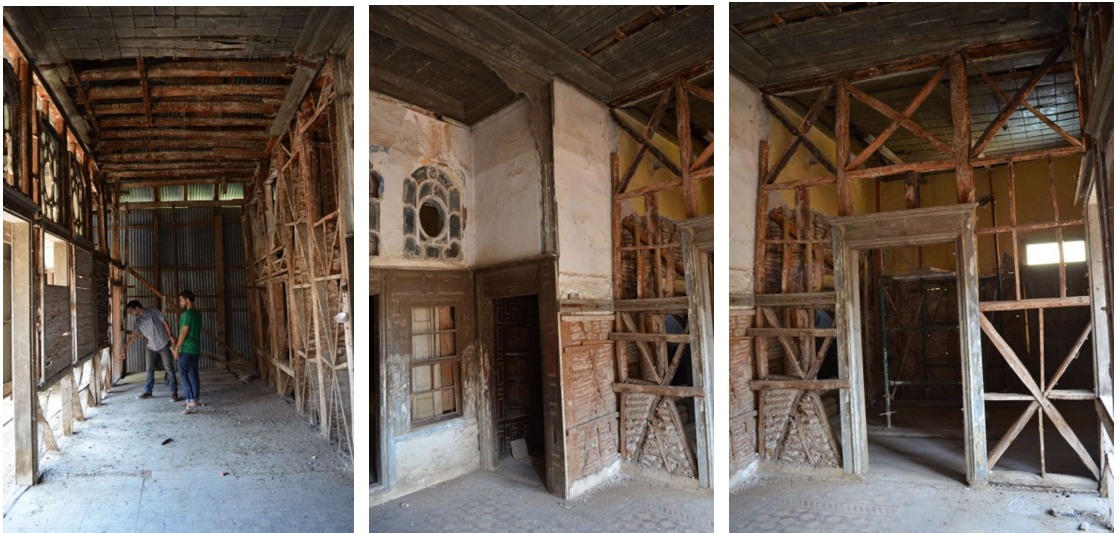
Χαγιάτι ορόφου (αριστερά). Η είσοδος από το χαγιάτι στον Ανατολικό οντά (κέντρο). Ο σοφάς στο ανατολικό άκρο του χαγιατιού. Διακρίνεται ο νεότερος ξυλόπηκτο τοίχος που κατασκευάστηκε
