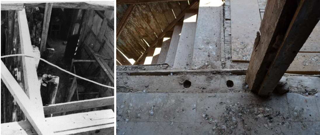
Κυκλικό μόρσο σύνδεσης υποστυλώματος με δοκό στη στέψη του (Αρχείο Εφορείας). Κυκλικές μορσότρυπες στον στρωτήρα της εσωτερικής κιονοστοιχίας στο χαγιατί.
