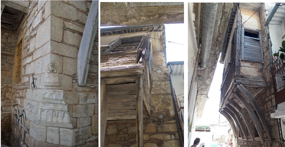
Λαξευτή διαμόρφωση της γωνίας του κτηρίου επί της οδού Παίδων. Αριστερά διακρίνεται η απότμηση της γωνίας και ο διάκοσμος της. Δεξιά η ΒΑ γωνία του κτηρίου και το σαχνισί.
