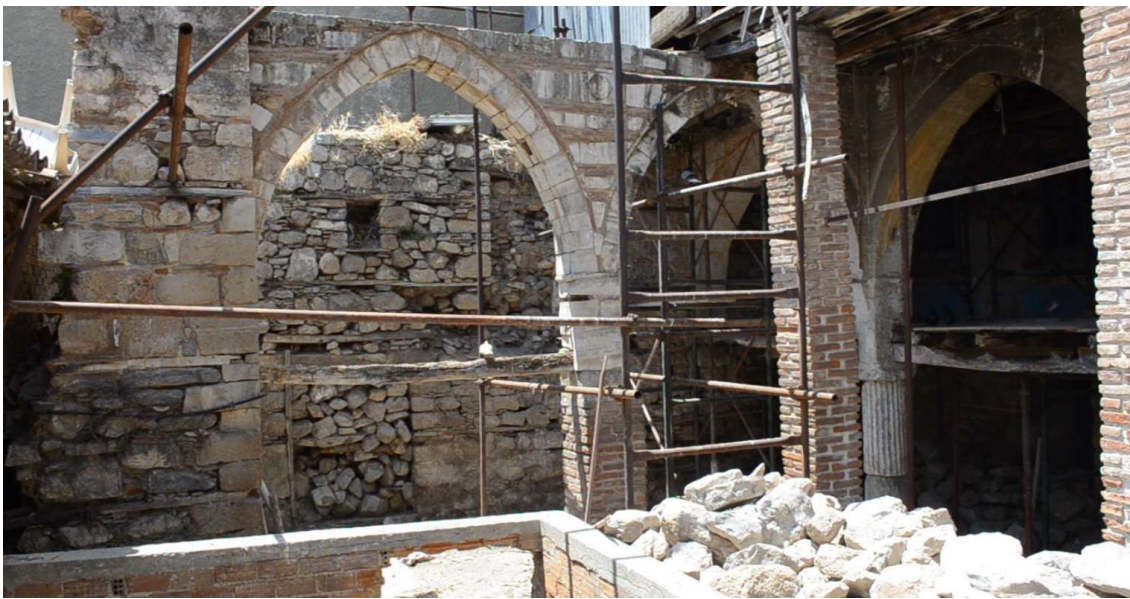
Αριστερά στην εσωτερική παρεία των τόξων διακρίνονται οι οπτόπλινθοι μεταξύ των λαξευτών λίθων. Εδραση μεσοπατώματος στην τοξοστοιχία.
