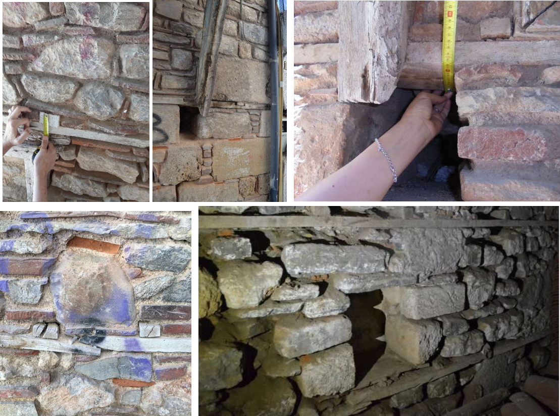
Ανατολική πτέρυγα. Διάταξη διαστάσεις και συνδέσεις ξυλοδεσιών.
