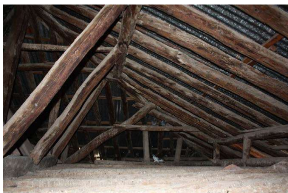
Αμείβοντες εδραζόμενοι στις διαμήκεις δοκούς. Διακρίνονται επίσης οι αντηρίδες στις οποίες εδράζονται οι διαμήκεις δοκοί (φωτ. Χ. Μπασούκος).
