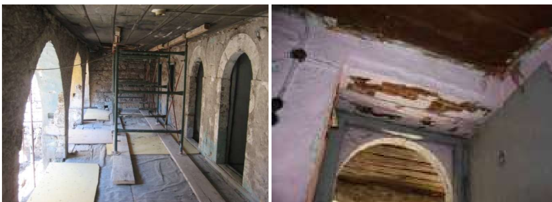
Διάδρομος μεσοπατώματος. Διακρίνονται οι τοξωτές θύρες (αριστερά) και η εσωτερική διαμόρφωση του ανωφλίου τους.
