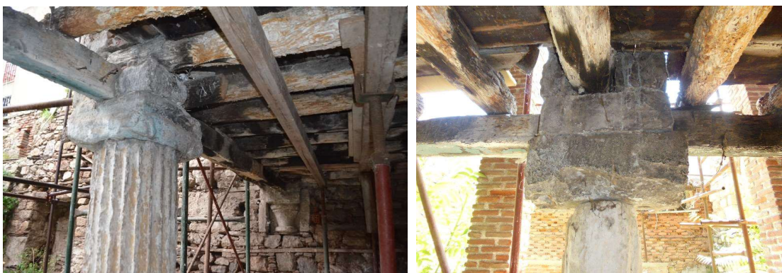
Έδραση δοκώνμεσοπατώματος στην κιονοστοιχία.
