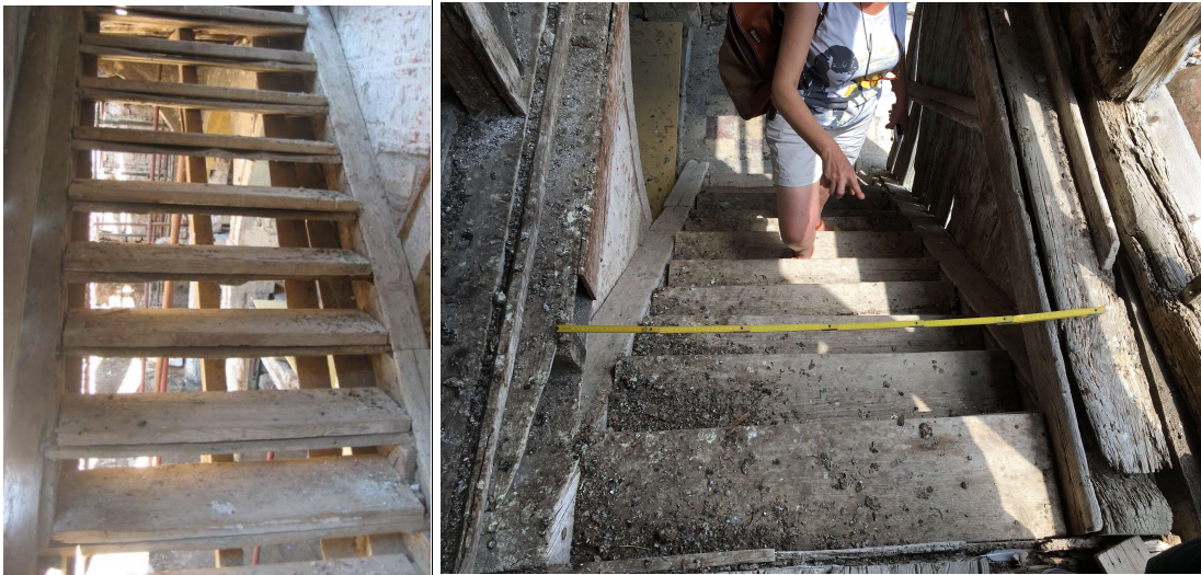
Σκάλα προς τον όροφο.
