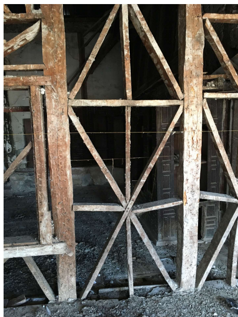
ΝΑ γωνία σαχνισιού. Διακρίνονται τα καρφιά για την πρόσφυση του κονιάματος. Εσωτ. ξυλόπηκτο. Διακρίνεται η επεξεργασία για την πρόσφυση του σοβά.
