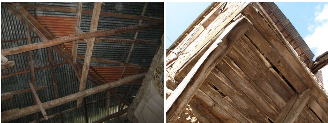
Αριστερά, η οροφή του Δυτικού οντά λείπει τελείως (φωτ. Μελέτη Παθολογίας). Δεξιά διακρίνεται η οροφή του ΒΑ σαχνισιού, η οποία παρουσιάζει σημαντικές φθορές.
