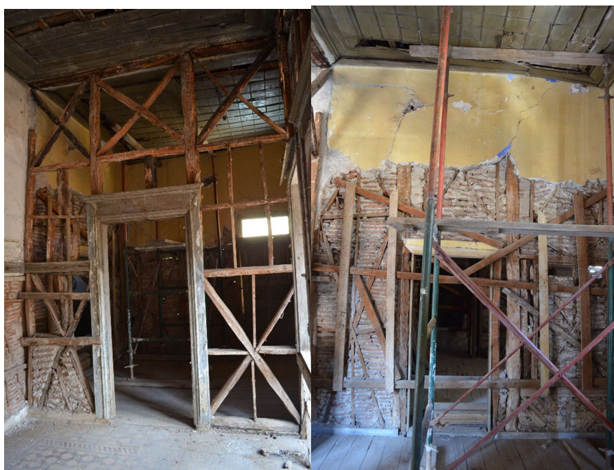
Εσωτερικοί ξυλόπηκτοι τοίχοι Ανατ. σοφά.
