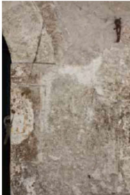
Ρωγμή και αστοχία στην έδραση του τοξωτού λαξευτού ανωφλίου (φωτ. Χ. Μπασούκος)
