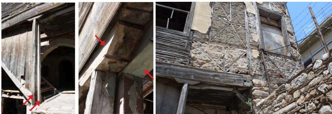
Διακρίνονται τα υποστυλώματα έδρασης του διαδρόμου του χαγιατιού. Το αρχικό πίσω και το νεότερο μπροστά.
