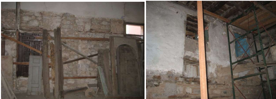
Ο βόρειος τοίχος του Ανατολικού οντά δεν παρουσιάζει σοβαρές βλάβες. Νότιος τοίχος δυτικού Δωματίου (ισόγειο και μεσοπάτωμα). Η κατάσταση του είναι καλή.
