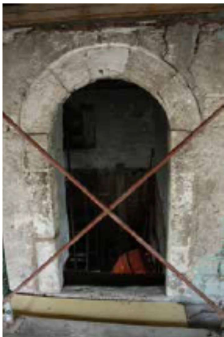
Ρωγμή και αστοχία στην έδραση του τοξωτού λαξευτού ανωφλίου (φωτ. Χ. Μπασούκος)
