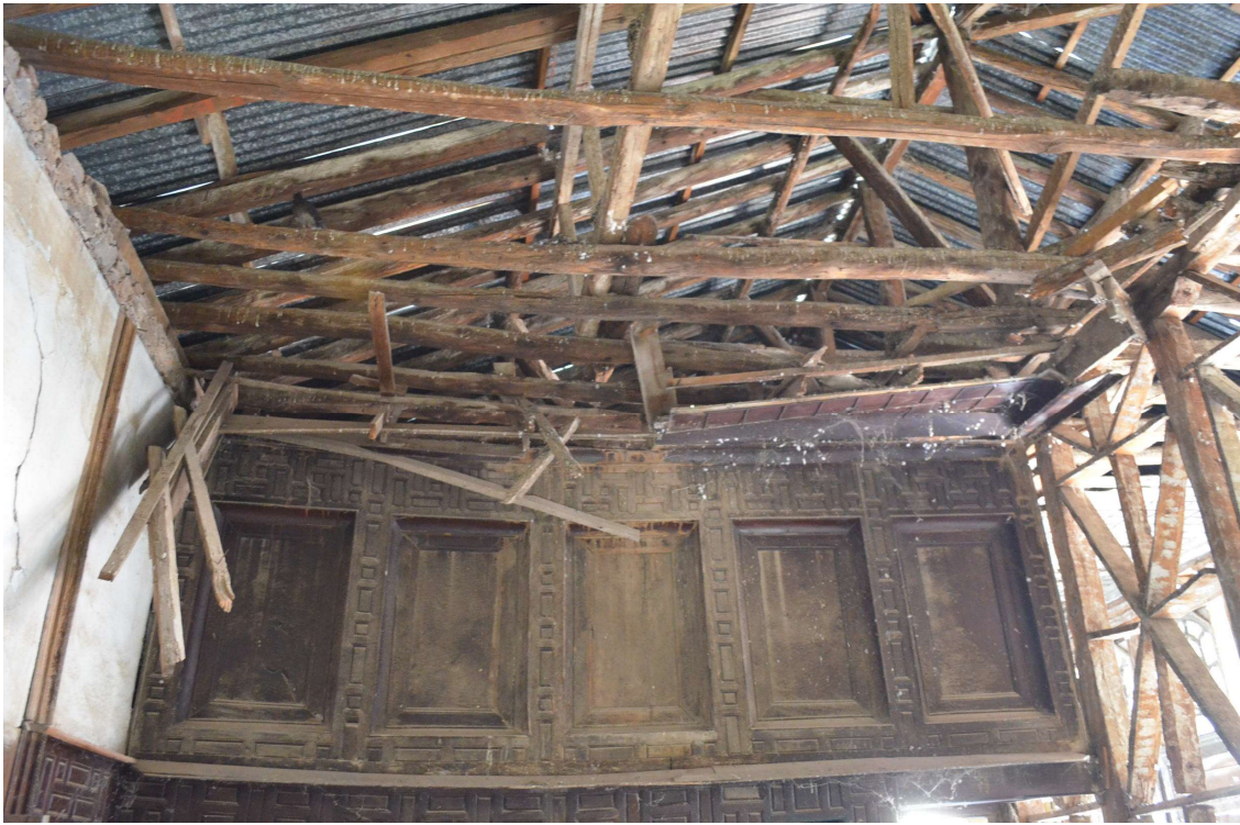
Στέγη στο Δυτικό δωμάτιο.
