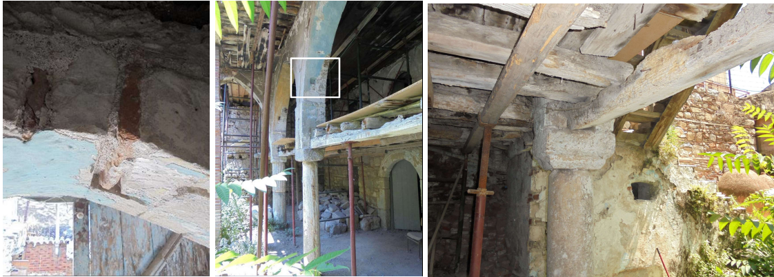
Αριστερά στην εσωτερική παρεία των τόξων διακρίνονται οι οπτόπλινθοι μεταξύ των λαξευτών λίθων. Εδραση μεσοπατώματος στην τοξοστοιχία.
