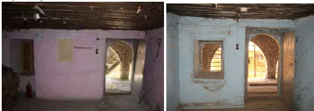
Όψη του νότιου τοίχου του ανατολικού και ενδιάμεσου δωματίου του μεσοπατώματος
