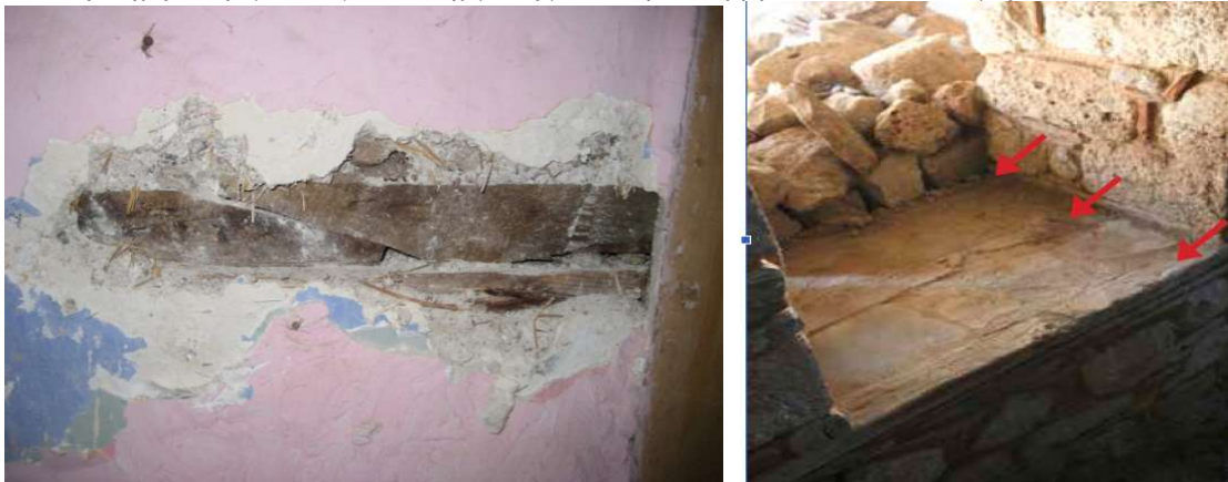
Λοξότμητη σύνδεση ξυλοδεσιάς στο Ανατολικό δωμάτιο του μεσοπατώματος. Τρεις ξυλοδεσιές στην ποδιά του παράθυρου του Δυτικού τοίχου στο ισόγειο. (Χ. Μπασούκος).
