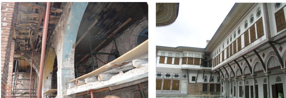
Έδραση διαδρόμου πριν το χαγιάτι. Παράδειγμα έδρασης ορόφου σε αντηρίδες που στηρίζονται σε τοξοστοιχία.
