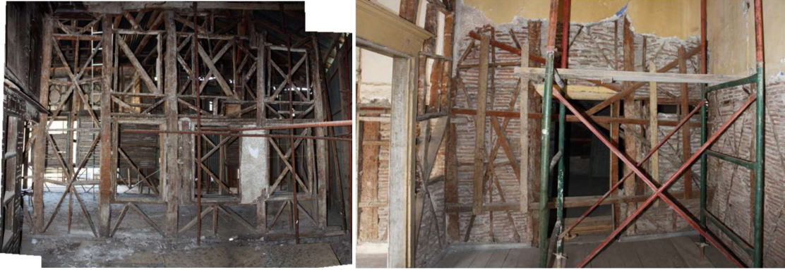
Εσωτερικοί ξυλόπηκτοι τοίχοι ορόφου (φωτ. Χ. Μπασούκος).
