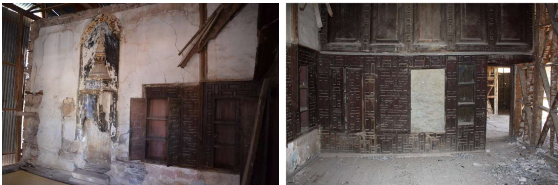
Δυτικός οντάς. Διακρίνεται ο Βόρειος τοίχος από λιθοδομή με το τζάκι και τα ερμάρια (αριστερά) και η μουσάντρα και η θύρα εισόδου στο δωμάτιο (δεξιά).
