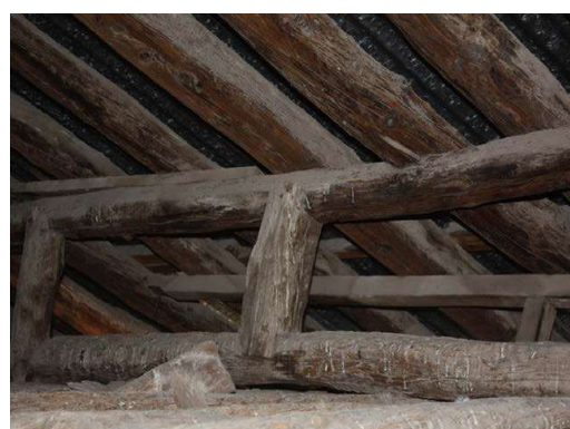
Αμείβοντες εδραζόμενοι στις διαμήκεις δοκούς. Διακρίνονται επίσης οι αντηρίδες στις οποίες εδράζονται οι διαμήκεις δοκοί (φωτ. Χ. Μπασούκος).
