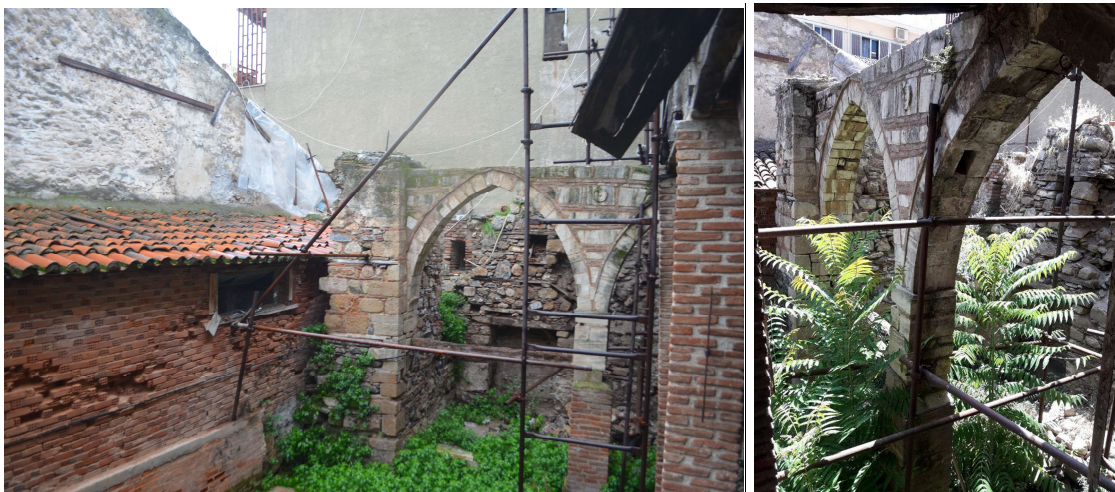
Νεότερο βοηθητικό κτίσμα στη Νότια πλευρά της αυλής.
