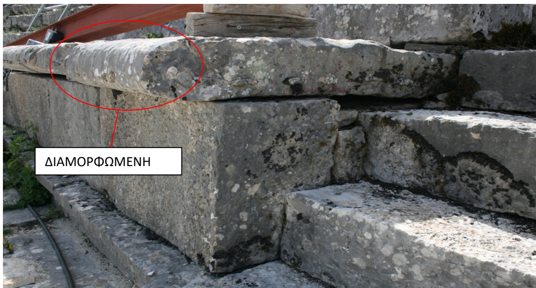
Εικ. 4: Κρ2Α01 : Διαμόρφωση όψης καταλυπτήρα του Α Διαζώματος (ΕΦΑΙ)
