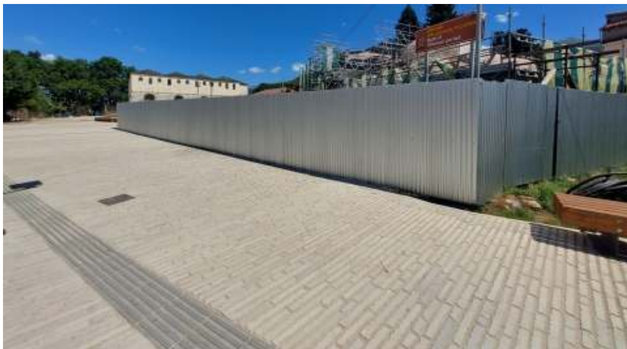
Φωτογραφία 1: Άποψη διαμορφωμένης πλατείας με φιλέτο 6x30x5 και πλάκες όδευσης ΑΜΕΑ.
