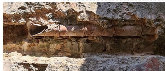
Σχήμα 1: Πήλινοι σωλήνες δικτύου διανομής κρύου και ζεστού νερού.
