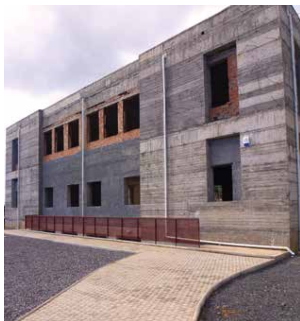
εικ. 130. Μερκοβούνι. Διαμόρφωση του περιβάλλοντος χώρου. fig. 130. Merkovouni. Configuration of the surrounding area.
