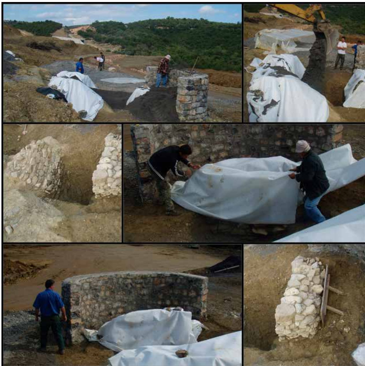
Εργασίες κατάχωσης – Reburial works
