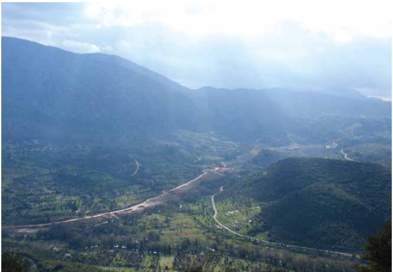
εικ. 68. Βελμινάτιδα Χώρα. Άποψη του υπό διάνοιξη αυτοκινητόδρομου από το λόφο του Χελμού. fig. 68. Belminatis. View of the under construction motoway from the Helmos hill.
