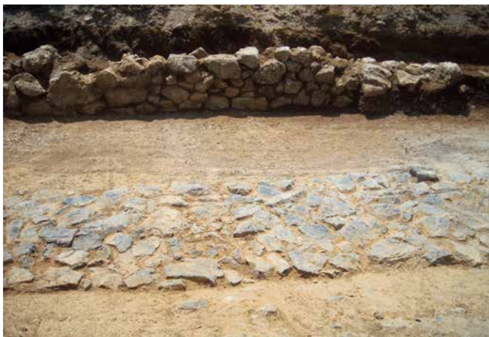
εικ. 6. Κόμβος Παλλαντίου. Οδός λιθαγωγίας - Αναλημματικός τοίχος. fig. 6. Pallantio intersection. Paved road that was used to carry stones to the quarry - Retaining wall.
