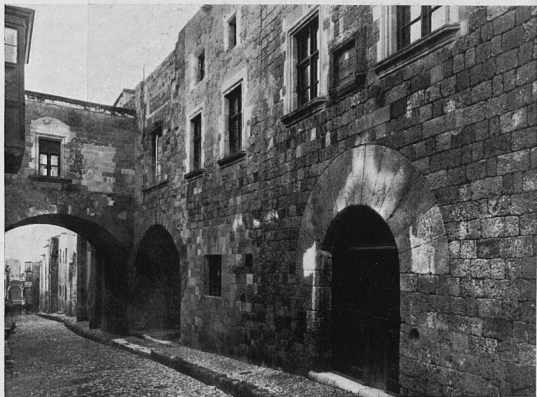
FIG. 125 — RODI - VIA DEI CAVALIERI: PROSPETTO DELL'ALBERGO DI SPAGNA RESTAURATO.
