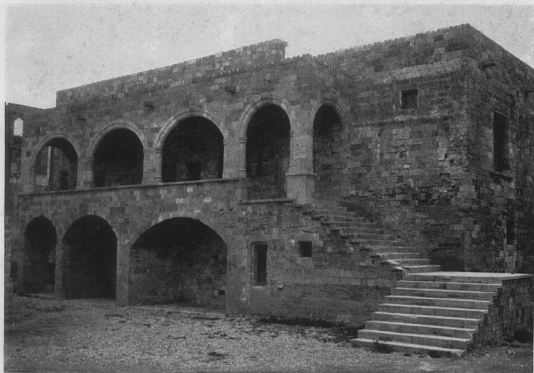
FIG. 131 — RODI - L'ALBERGO DI ALVERNIA DOPO IL RESTAURO.
