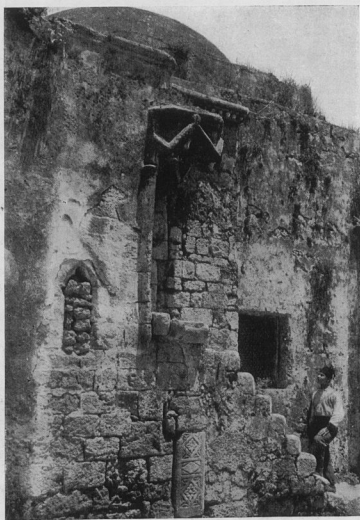
FIG. 120 — RODI - VIA DEI CAVALIERI: CAPPELLA CAVALLERESCA PRIMA DEL RESTAURO.
