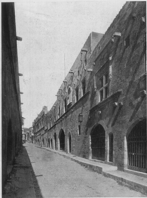
FIG. 116 — RODI - LA VIA DEI CAVALIERI DOPO IL RESTAURO.
