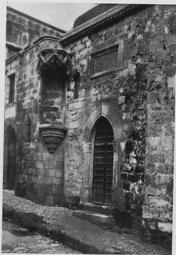
FIG. 121 — RODI - VIA DEI CAVALIERI: CAPPELLA CAVALLERESCA DOPO IL RESTAURO.
