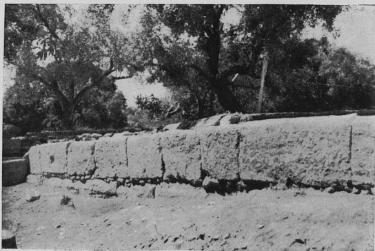
FIG. 54 - IL MURO EST DELL'AMBIENTE I, DALL'ESTERNO
